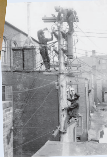
Installation von Elektrokabeln Foto: Allen Ayrault
